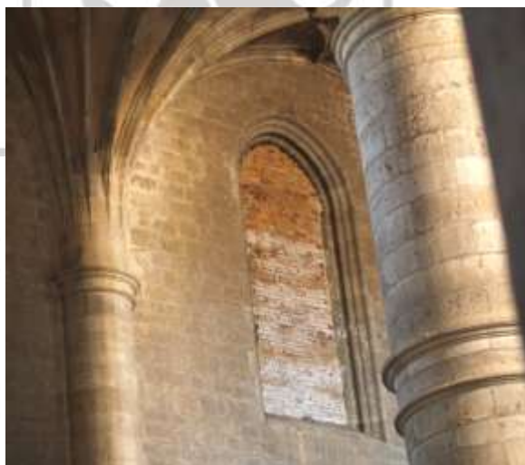
Ventana tapiada, considerada como “laguna completa”.
