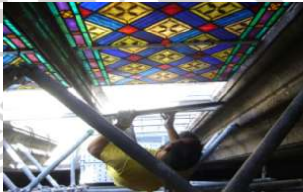
Montaje de vidriera con el sistema de protección “acristalamiento isotérmico”
